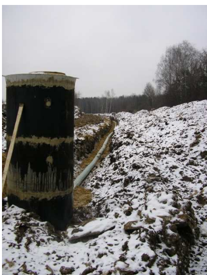
Рис.20 Строительство дренажной системы для сбора и удаления фильтрата
