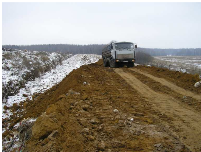
Рис. 19 Устройство дамбы обвалования. 2008г.
