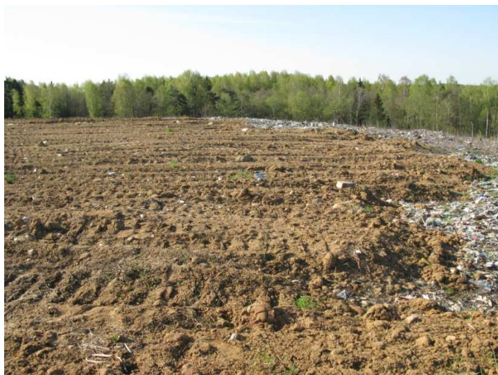
Рис.22 Технический этап рекультивации полигона ТБО у д.Разлукино 2008г.
